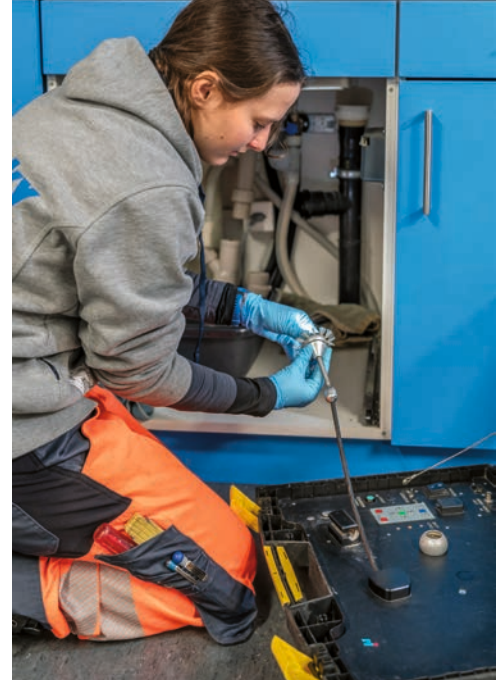
➤ Pour nettoyer une conduite, Livia Lüdi utilise un embout équipé d'une brosse.
